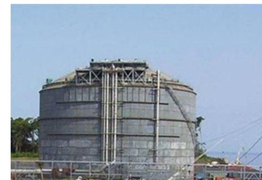
LNG Storage Tank
